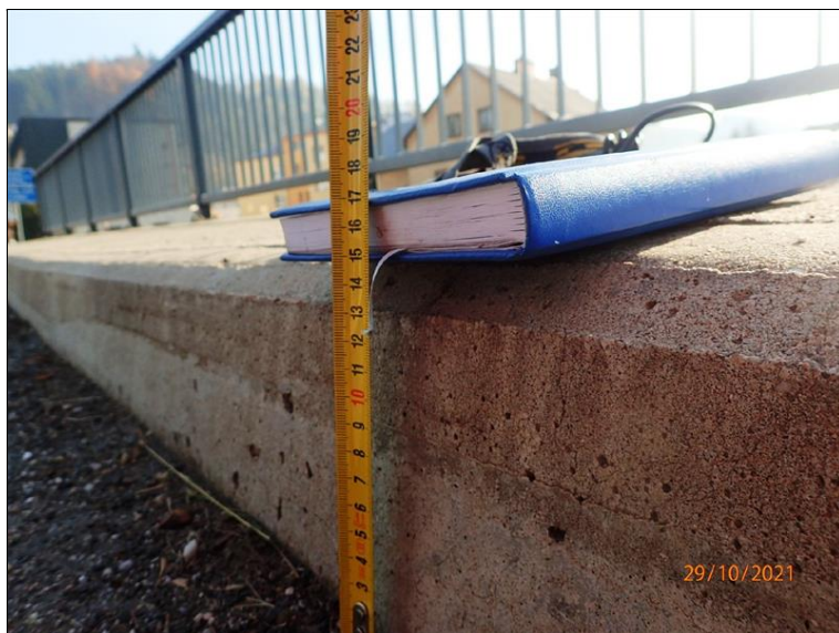
Vozovková obruba L římsy, cca 1/2 rozpětí NK, naměřena výška = cca 15 cm.
