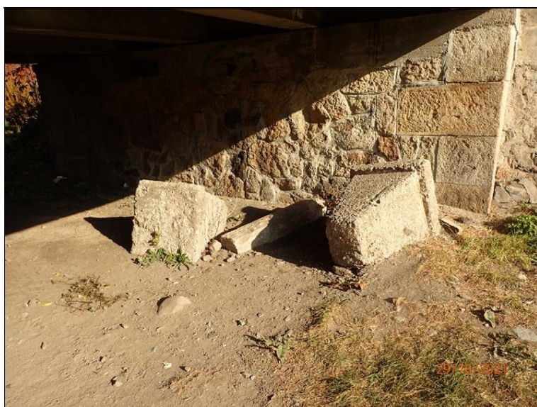
Mostní otvor, betonové prvky uložené před lícem O1 = odpad.
