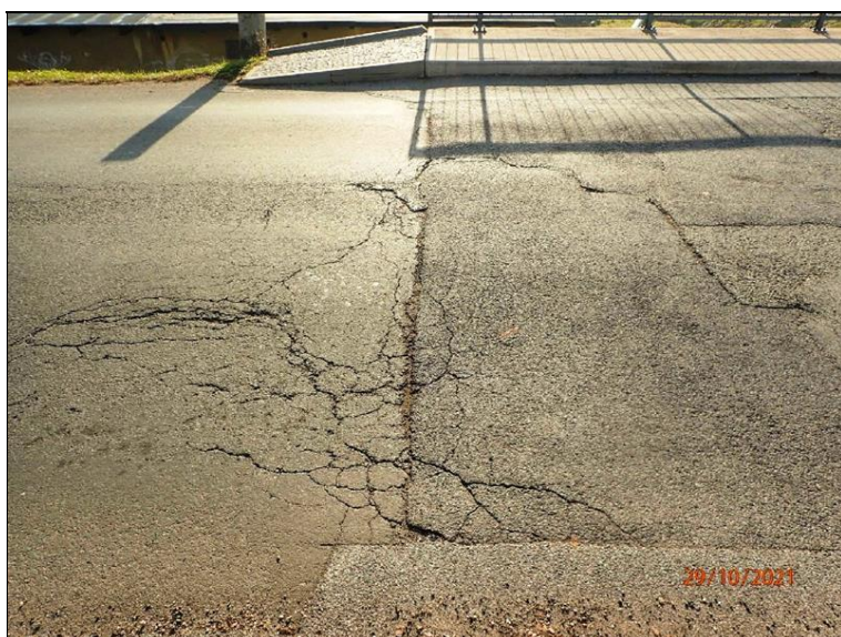
Aktuální stav krytu vozovky v oblasti před O1.
