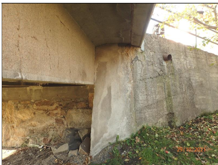
P strana opěry O1, P křídlo - předsazená omítnutá přibetonávka.
