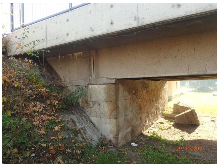
P bok + křídlo opěry O1, zpevněný svahový kužel.
