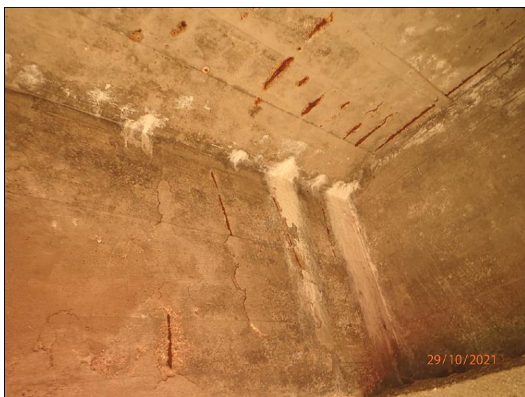
Podhled NK, průsaky s výluhy a poruchy výztuže na vnitřním boku trámu 1L + mostovce, úsek před O2.
