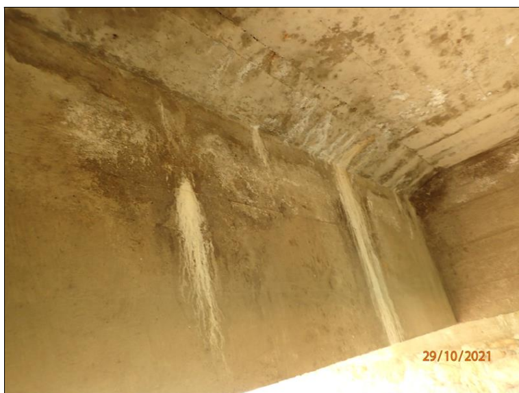
Podhled NK, průsaky s výluhy vycházejí ze styčného koutu mostovky s trámem 2P, úsek před O2.
