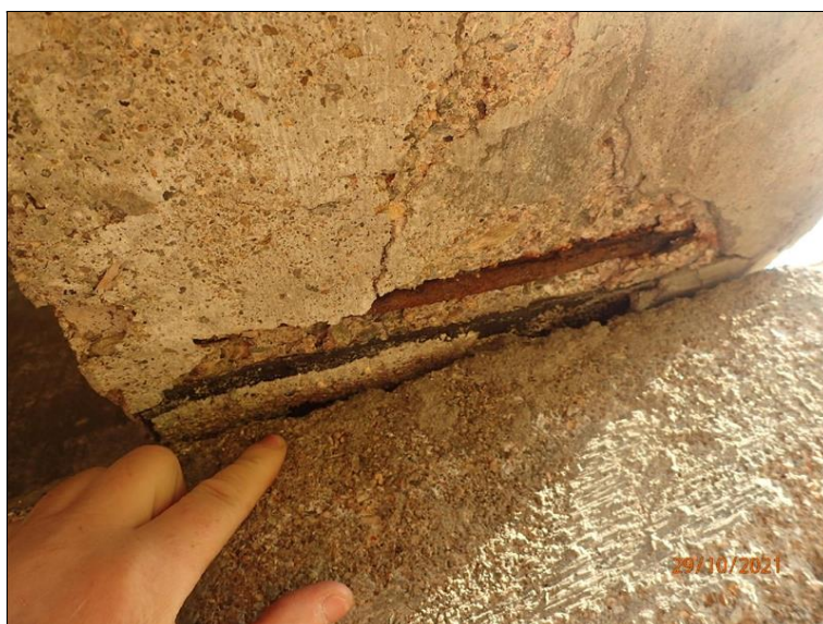
Detail kluzného uložení trámu 1L na O1, separační vložka, nejspíše asfaltová lepenka.
