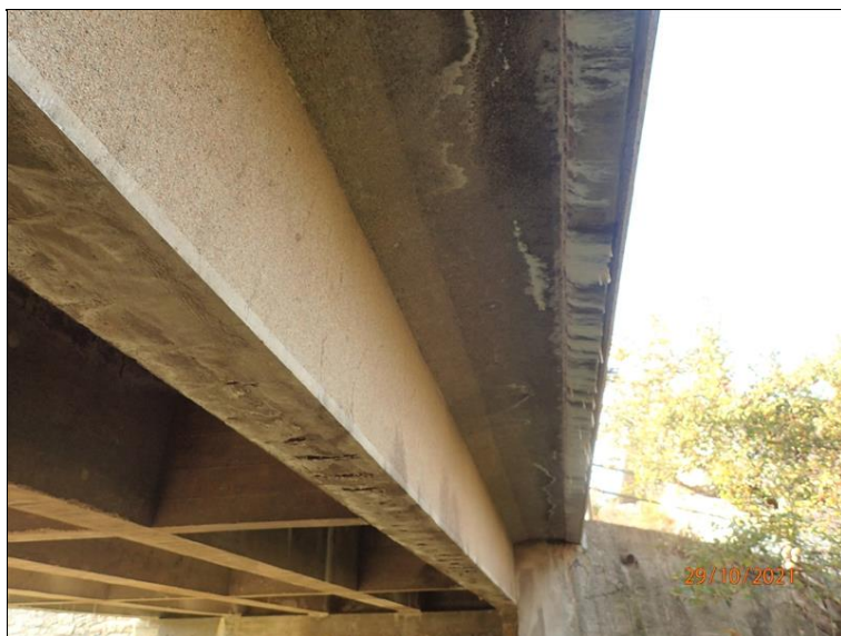
Krajní 1P trám od O1, pohled podchodníkové konzoly a římsy.
