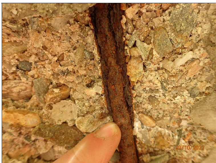
Detail z výše uvedené foto, porucha krycí vrstvy, vrstevnatá koroze třmenu na podhledu trámu 1L - častá porucha.
