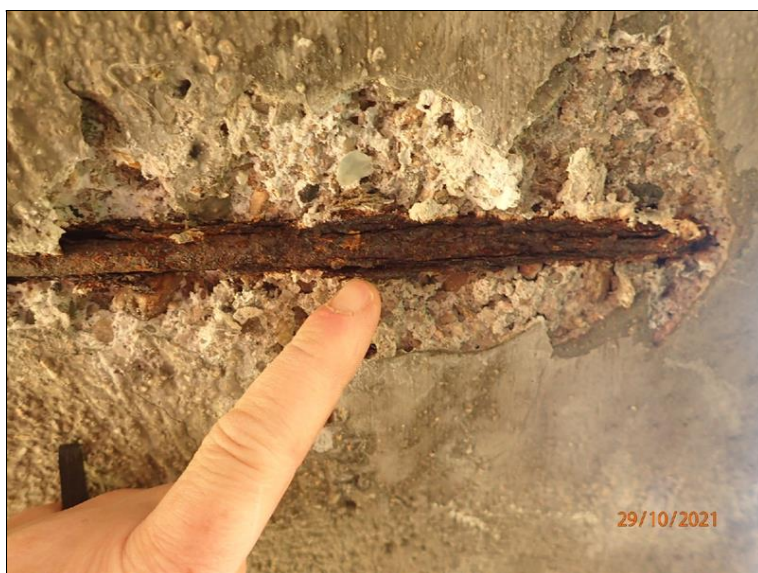
Detail z výše uvedené foto, koroze třmenů na podhledu 1P trámu - častá porucha.
